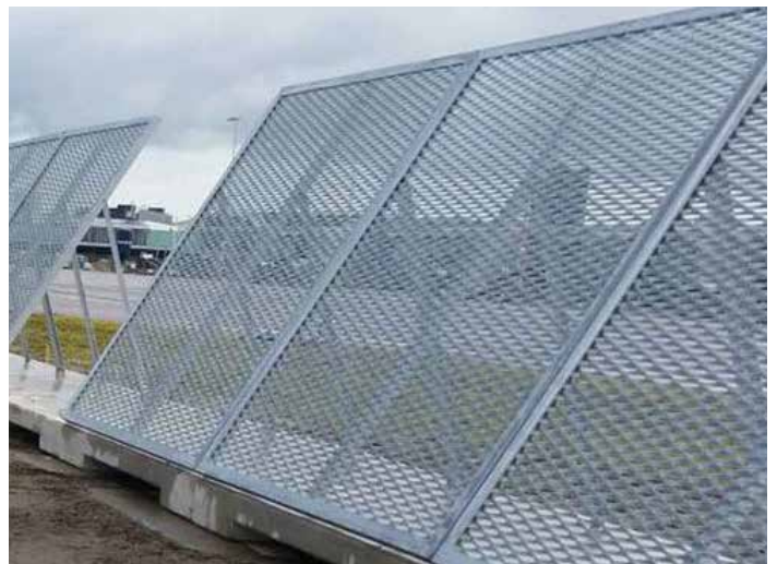
Sikkerhetsgjerde som styrer vind (blast-fence)
