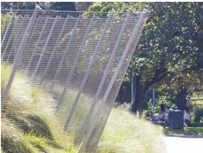
Sikkerhetsgjerde som hindrer adgang til helikopterlandingsplass
